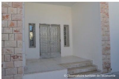
Photo 5 : Projet de développement public suivi au cours de notre étude : Développement du centre élémentaire de chott Essalem du type 3 au type 4
